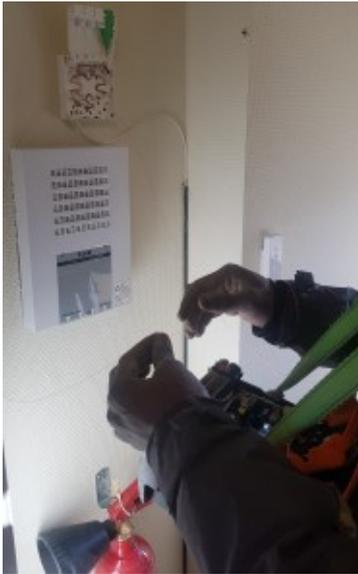
La fibre arrive directement en un seul câble du PBO à la prise optique installée à un endroit stratégique du bâtiment.
