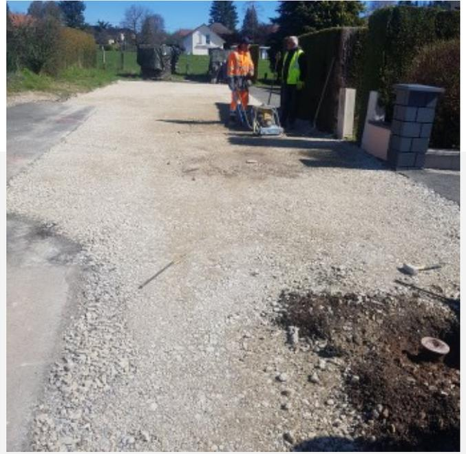
Dans les secteurs fortement dégradés, suivant les préconisations des experts, il convenait de renforcer la structure profonde de la chaussée.
