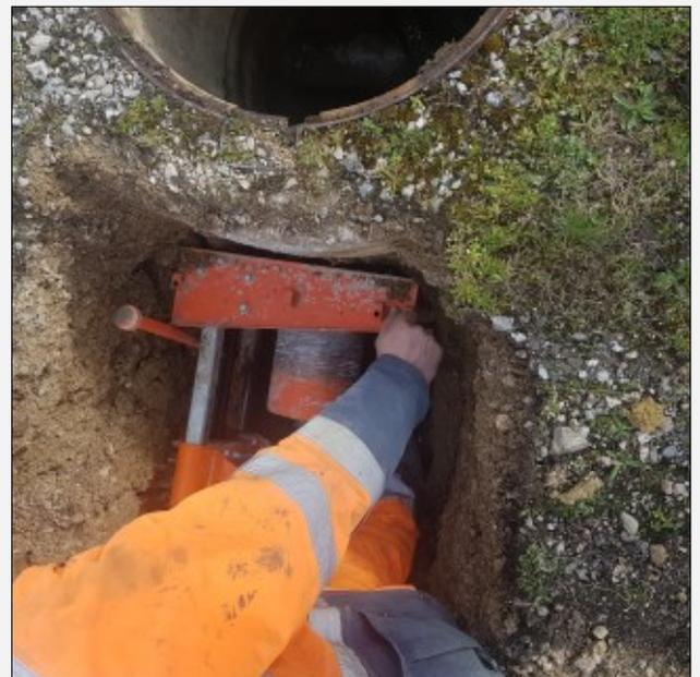
Le raccordement au réseau principal de plus gros gabarit se fait après carottage d'un regard préexistant.
