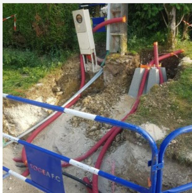
Installation de souches en béton pour supporter les poteaux munis de candélabres assurant l'éclairage public avec des LED.
